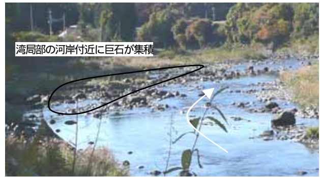
写真-5 余笹川3k付近の水衝部(H20.11.14撮影)
