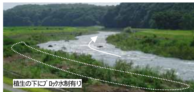
写真-7 余笹川9.2k付近の湾曲部(H20.8.6撮影)
