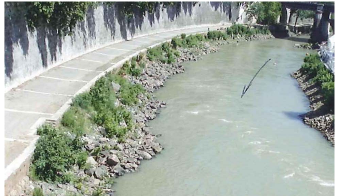
写真-1 テベレ川のトリピラ水制(捨石工の変形)
