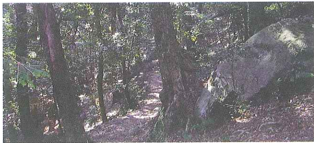
遊歩道（落石が樹木に衝突して止まっている）
