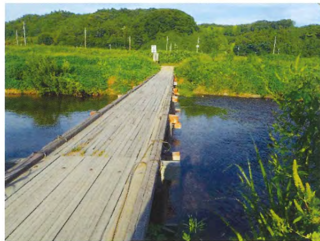
写真-41 里川の流れ橋「西宮橋」(H30 (2018))
