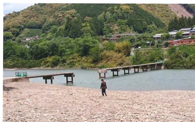
写真-39 岩間沈下橋（出典：10）
