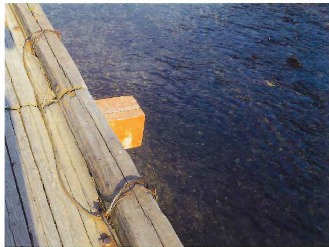
写真-42 西宮橋のロープ (H30 (2018))
