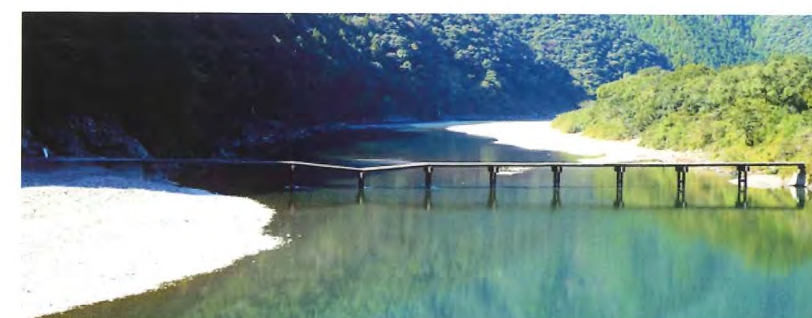
写真-38 岩間沈下橋（出典：12）
