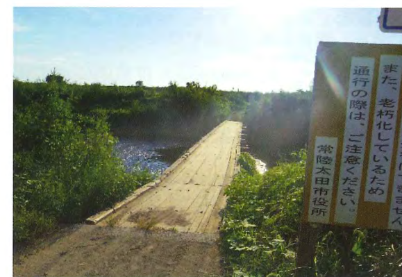
写真-9 西宮橋 (H30 (2018))
