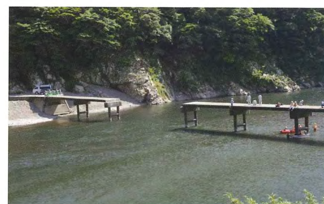
写真-40 岩間沈下橋（出典：8）
