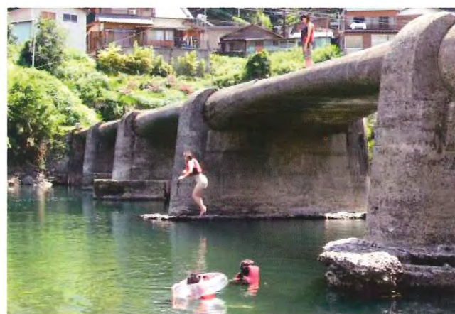
写真-33 口屋内沈下橋（出典：8）
