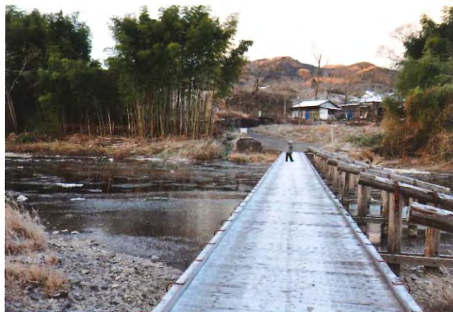
写真-27 久野瀬橋 (H22 (2010))
