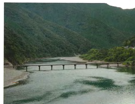
写真-37 岩間沈下橋（出典：11）
