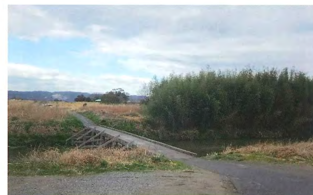
写真-2 八幡橋 (H30 (2018))
