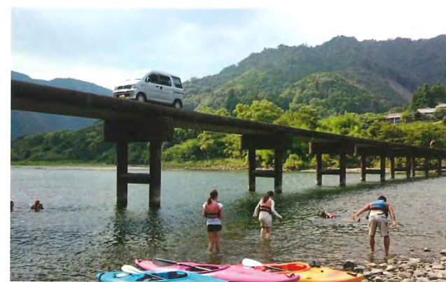
写真-35 岩間沈下橋（出典：10）
