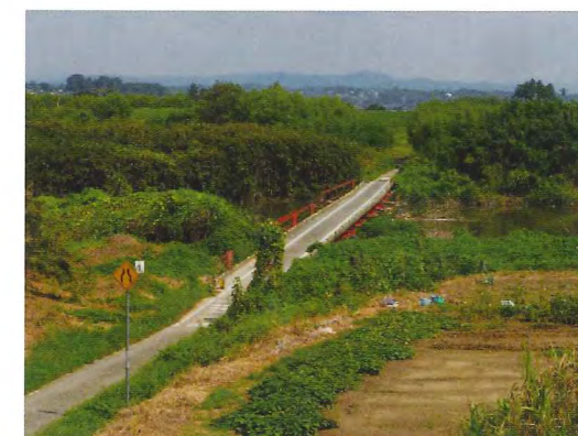
写真-20 木崎橋 (H30 (2018))
