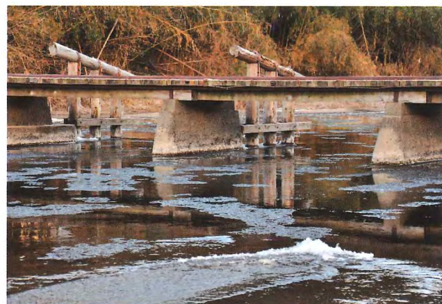
写真-28 久野瀬橋 (H22 (2010))
